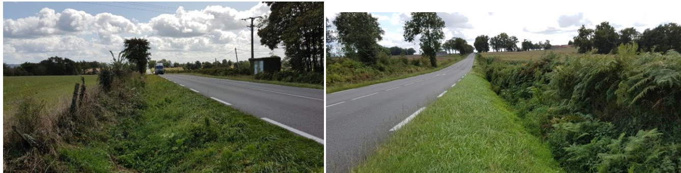
Photo 17 : Fossés présents sur la section Chamborêt
