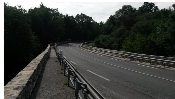
Photo 9 : Franchissement du Vincou par la RN147 entre les deux sections
