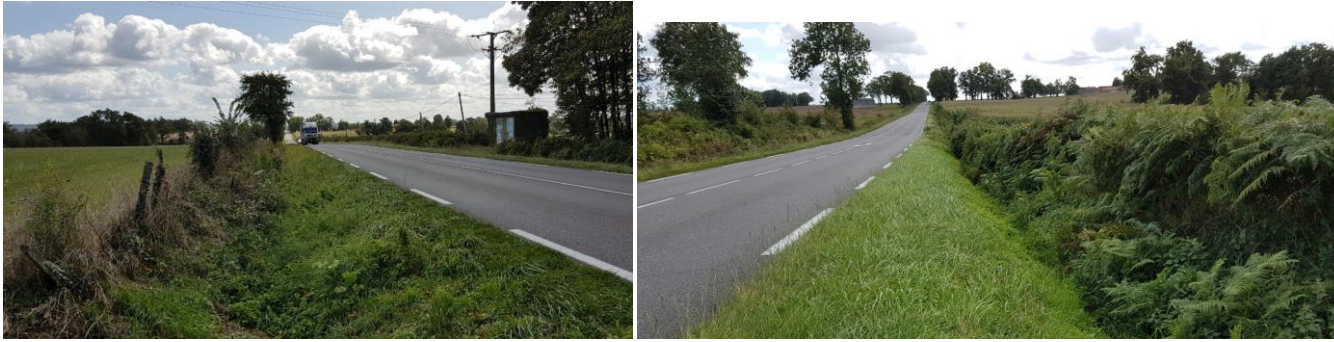
Photo 2 : Fossés présents sur la section Chamborêt
