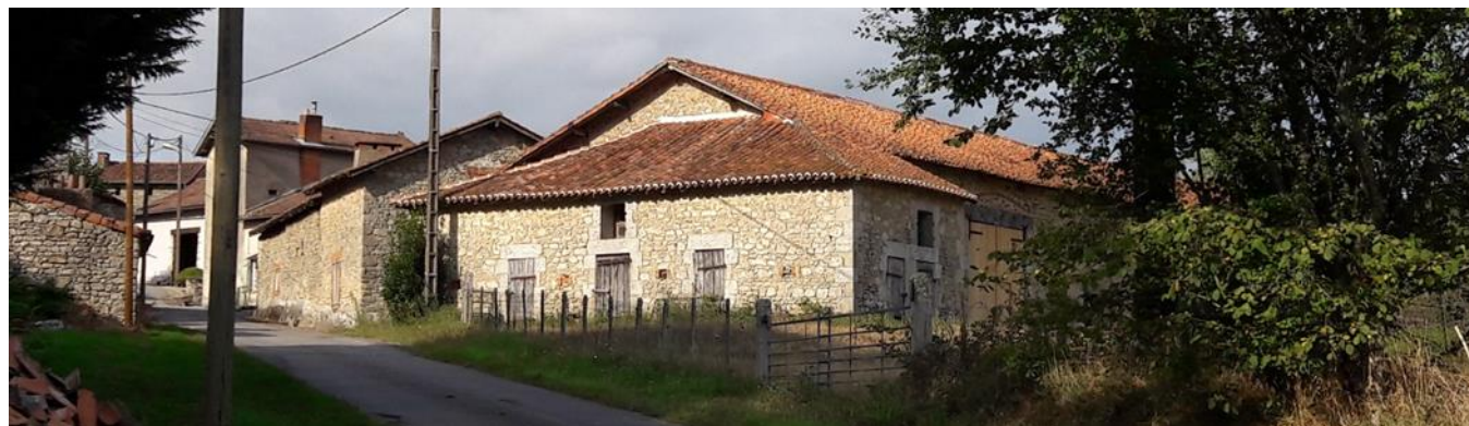
Photo 8 : Bâti traditionnel au hameau Fianas sur le secteur de Chamborêt
