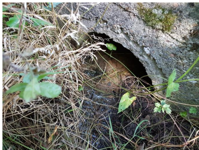
Photo 13 : Buse diamètre 500 en traversée de chaussée au droit du point bas n°2 avec léger écoulement d'eau
